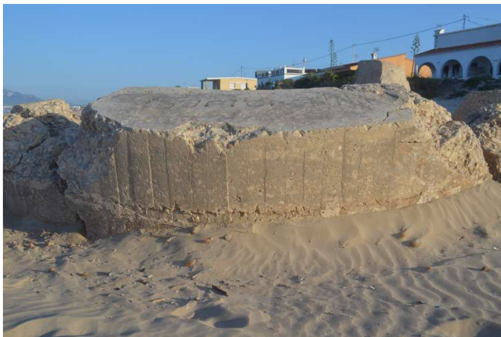
A.M.G. 007. Fotografia de detall. Taulons de l'encofrat. Casamata les Deveses I.
