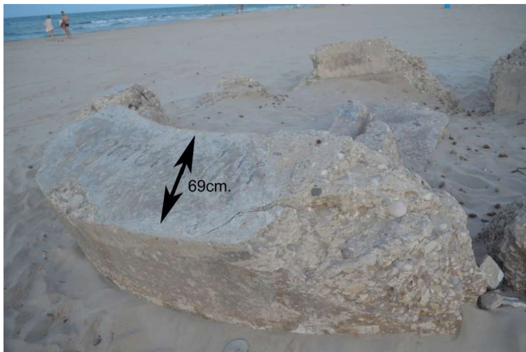
M.G.P. 003. Amplària dels encofrats. Casamata les Deveses I.
