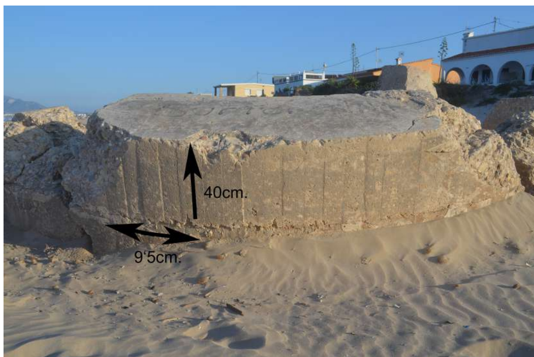
M.G.P. 004. Alçària i amplària d'un dels encofrats. Casamata les Deveses I.
