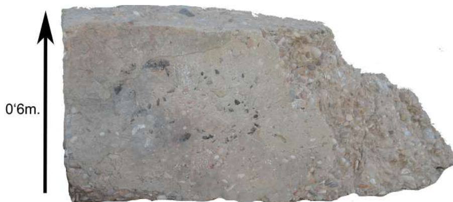
M.G.P. 002. Alçària dels encofrats. Casamata les Deveses I.
